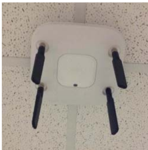
図 9-2 アンテナが同じ方向に（正しく）向けられた AP
