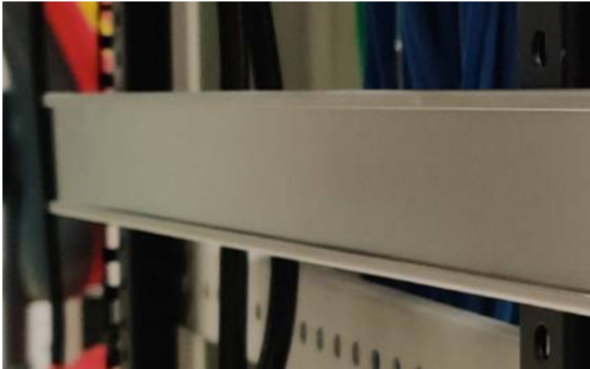
図 8: 左側レールを取り付けます。
