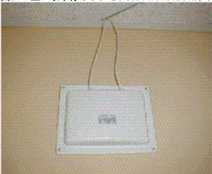
図24 : 壁に取り付けられたCisco Aironet 2012アンテナ
