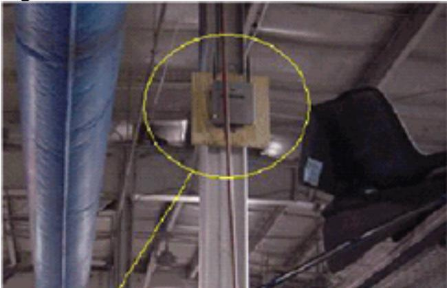
La Figura 18 mostra le variazioni o le distorsioni della propagazione del segnale causate da un fascio I. Il raggio I crea molti riflessi sia dai pacchetti ricevuti che da quelli trasmessi. I segnali riflessi determinano una qualità del segnale molto scadente a causa dei punti nulli e dell'interferenza a percorsi multipli. Tuttavia, la forza del segnale è alta perché le antenne del punto di accesso sono così vicine al raggio I.
