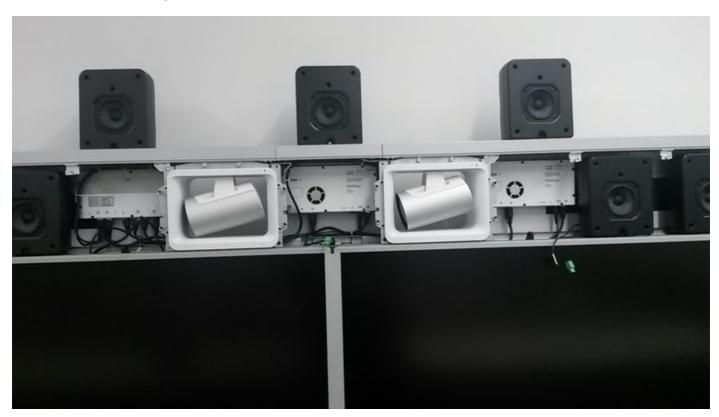
Paso 3. Para reajustar las cámaras solo, vaya al lado derecho de cada cámara, usted puede ver una fan en cada dispositivo tal y como se muestra en de la imagen.
